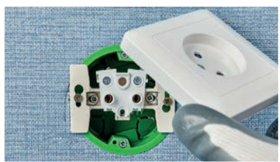
Fig. 11. Montare priză
